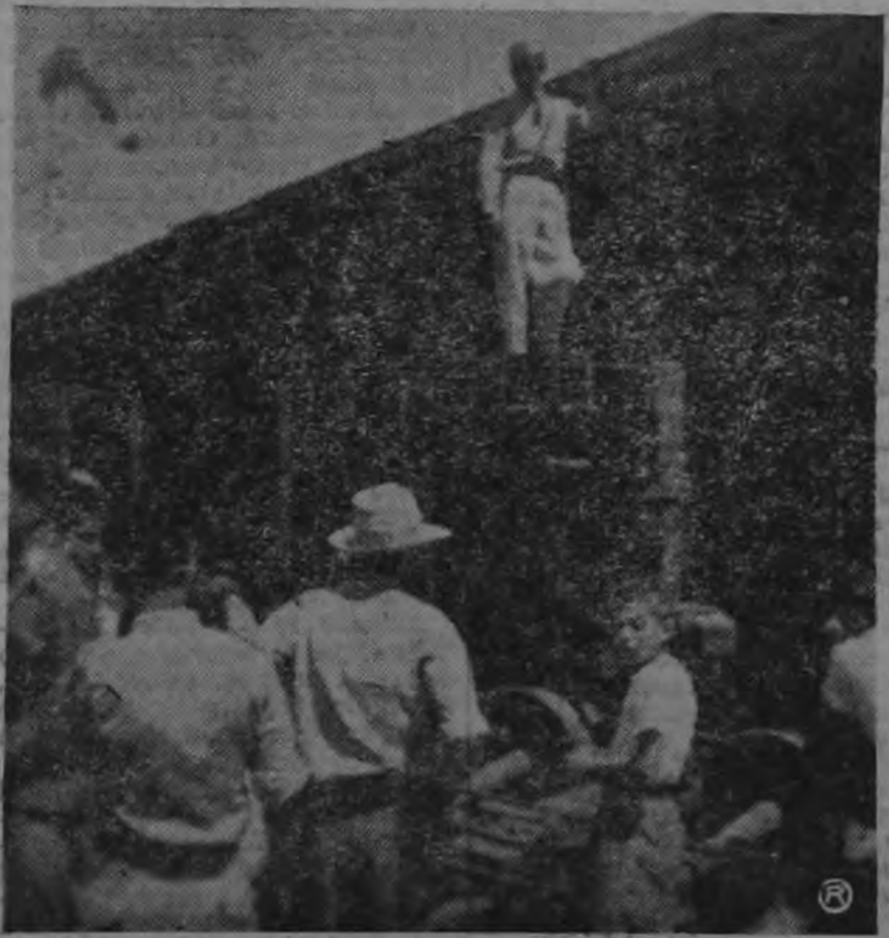
Los aspectos de la forma en que quedaron los vagones del tren que iba de San José hacia Limón, con gran cargamento de madera, cuando descarriló al pasar por la estación de Cartago. Al salirse de la vía, destrozaron parcialmente un edificio, sin producir daños personales graves que lamentar.
